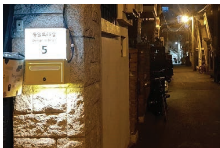
어두운 골목길의 조도 확보가 가능한 태양광 LED 조명 우체통 [서울시 광진구 군자동]
