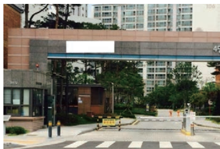
주,부 출입구에 차량 출입 차단기와 경비실 함께 설치
