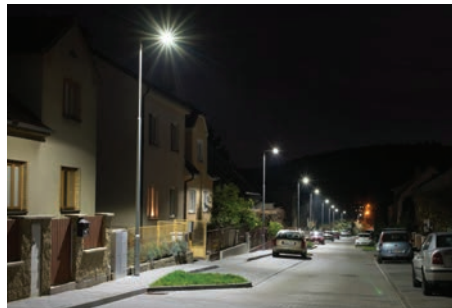
LED 조명 설치를 통한 조도 및 효율성 확보 [체코 Česká u Brna 마을]
