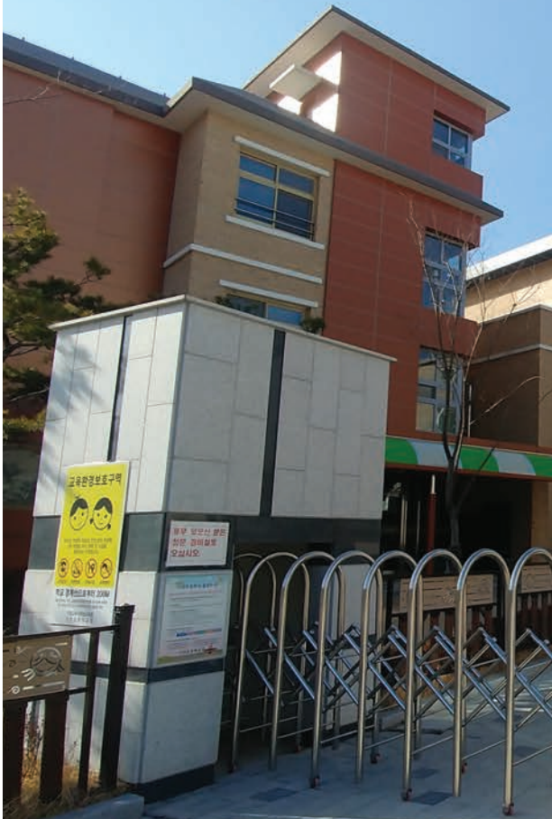
통제가 가능한 출입문 설치와 방문 절차 및 유의사항 안내 표지판 설치 [경상남도 거제시 기성 초등학교]
