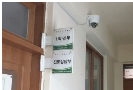
모든 건물 출입구에 CCTV와 조명 설치 [서울시 강동구 성덕여자중학교]
