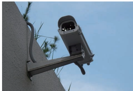
단지 경계부 담장에 방법용 CCTV 설치
