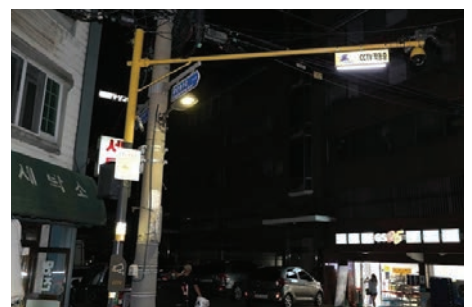
야간시 잘보이는 CCTV 및 비상벨 LED 안내판 [서울시 관악구]
