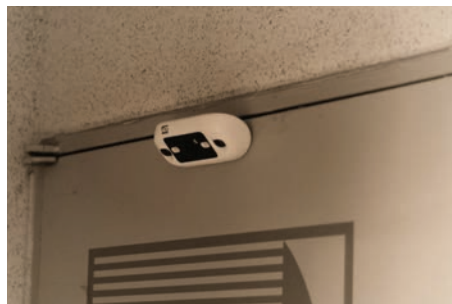
단위세대 현관문에 감시시설 설치
