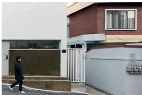
주택사이 이격공간에 투시형도어 설치 [경상남도 창원시]
