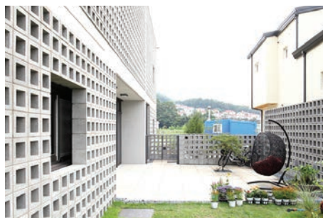
이웃 간 프라이버시와 소통을 고려한 주택 담장 투시형 콘크리트 블록 담장 [전원속의내집]
