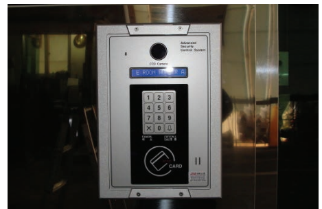
주동 출입구에는 접근통제 시설 설치
