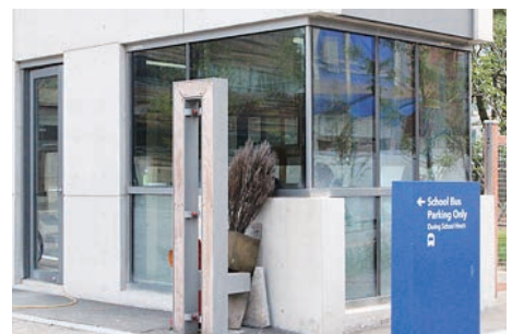
주,부 출입구 경비실 3면 이상 투시형 구조로 디자인과 CCTV 모니터링 시스템 설치
