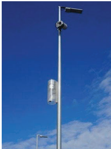
IoT와 BIG-DATA를 활용한 스마트 가로등, 스마트주차알림, 총성에 반응하여 신고가능, 사람의 움직임에 따라 빛의 밝기 조정 가능 [좌:스페인 바로셀로나 / 우:미국 샌디에고]
