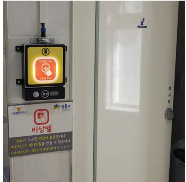
화장실 내부에 비상벨 설치 [서울시 성동구 공중화장실]
