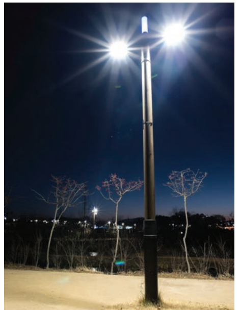
IoT와 BIG-DATA를 활용한 스마트 가로등, 스마트주차알림, 총성에 반응하여 신고가능, 사람의 움직임에 따라 빛의 밝기 조정 가능 [좌:스페인 바로셀로나 / 우:미국 샌디에고]
