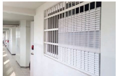
편복도에 면한 단위세대의 창문에 강화된 보안장치 설치
