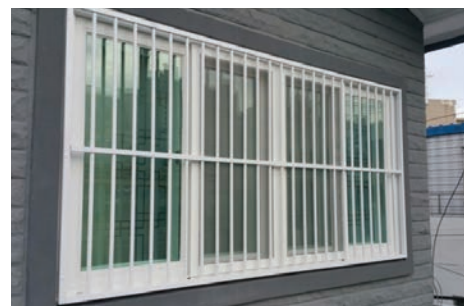
저층 주거지나 측벽에 위치한 창문에는 강한 충격에도 파손되지 않는 방범창 설치
