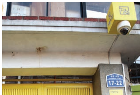
공동주택 출입구에 보안시설 설치 [서울시 마포구 염리동]
