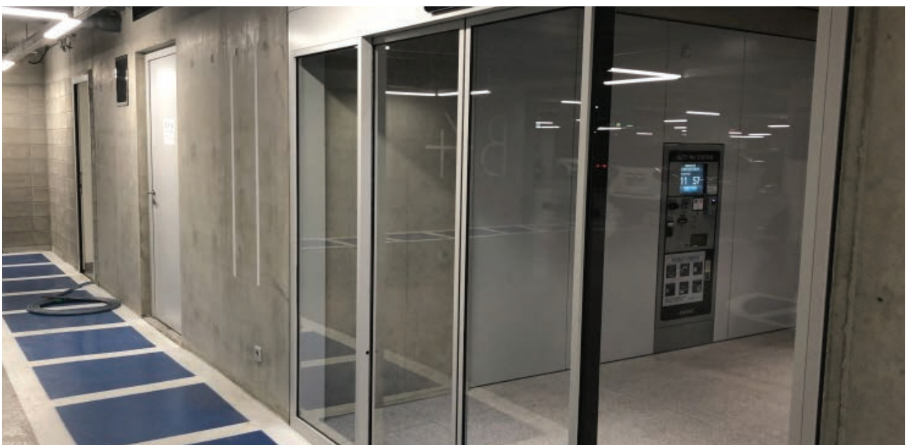
지하 주차장에서 지상으로 연결되는 코어부는 조명시설과 보안 시스템을 설치하고 투시형 구조로 계획
