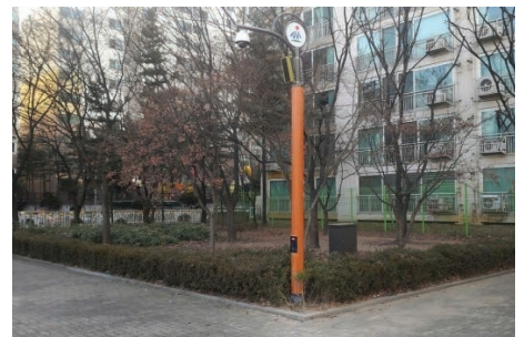
공원주변 CCTV비상벨 설치 [서울시 강서구]
