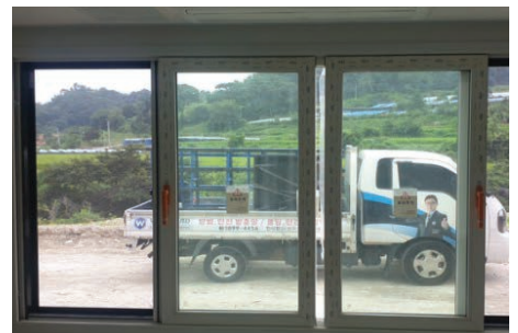
스텐레스망과 이중잠금장치가 설치된 창살없는 방범창 [왼쪽: 외부/오른쪽:내부]
