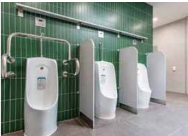
장애인 손잡이가 설치된 바닥형 소변기
