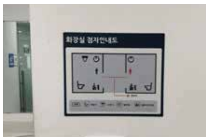
출입구 주변 촉지도식 안내판 설치 예시
