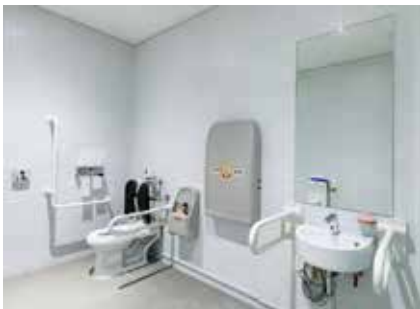
다목적화장실 편의시설 설치 예시
