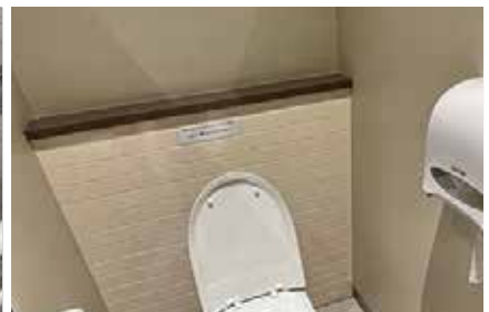
변기 후면에 설치된 선반
