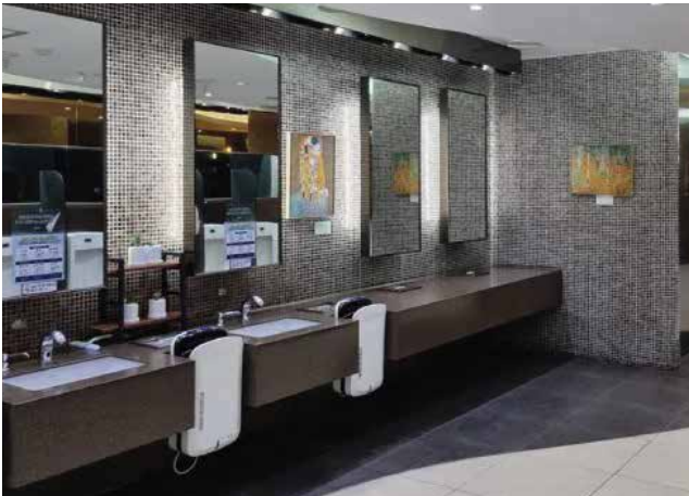
세면대 주변 핸드 드라이어 설치
