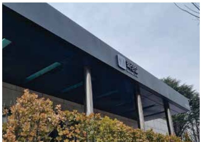
건물상단 안내표지를 설치한 건물 정면 모습
