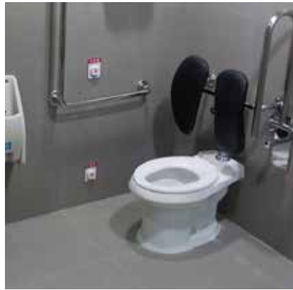
대변기 등받이가 있는 설치 예시
