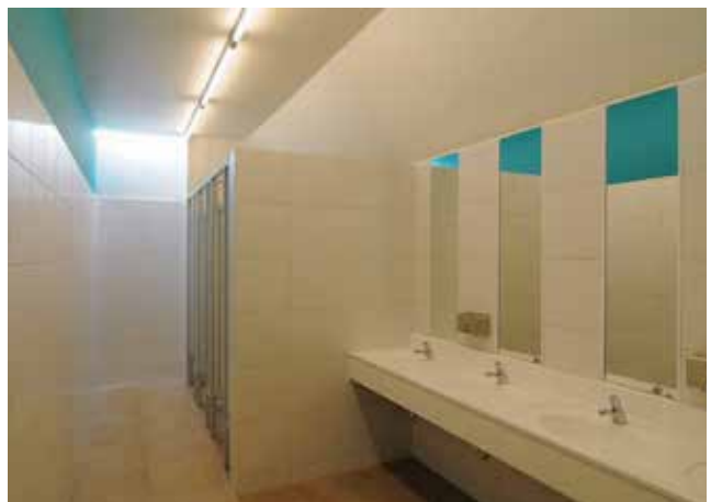
화장실 내부 조도 유지를 위한 조명 설치
