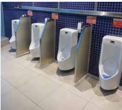
벽면부착형 소변기 설치 예시
