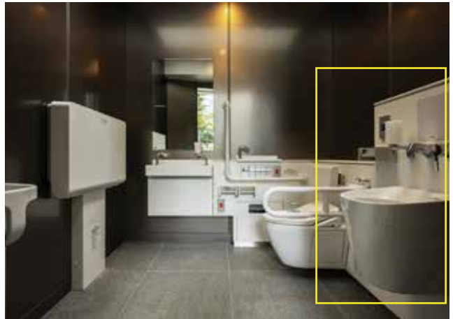
배뇨기능 장애인(장루, 요루 환자 등)을 위한 세척용설비(오스트메이트) 설치 예시
