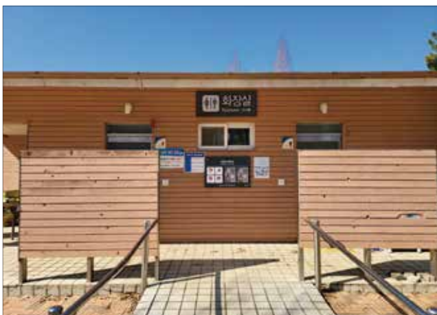
건물상단정면 안내표지, 안내게시판을 적용한 건물 정면 모습
