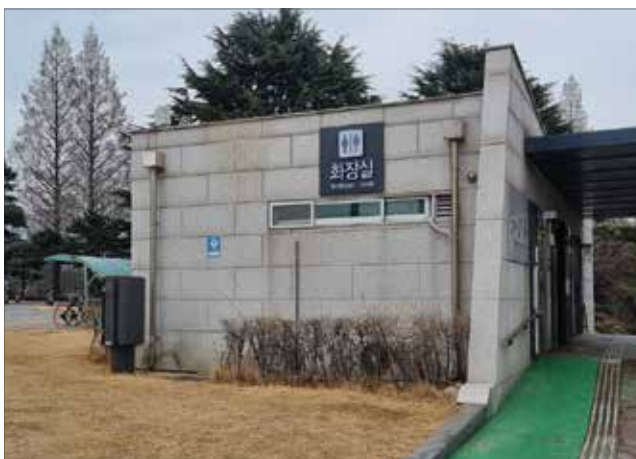
건물상단측면 안내표지를 설치한 건물 측면 모습
