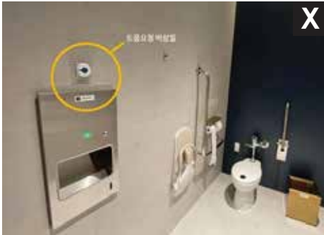
[그림1] 이용자의 편의를 고려하지 못하고 비상벨 위치를 선정한 사례(X)
