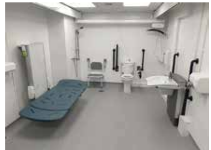
특수설비가 배치된 다목적화장실 예시
