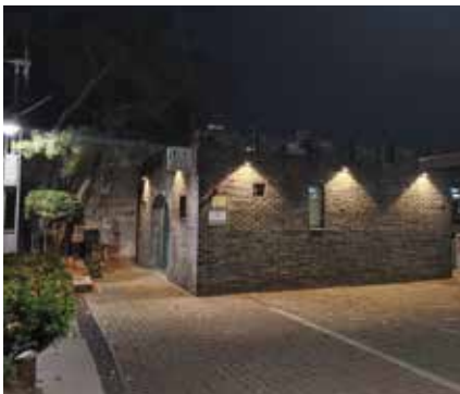
외벽 LED 조명설치로 야간 안전성 확보
