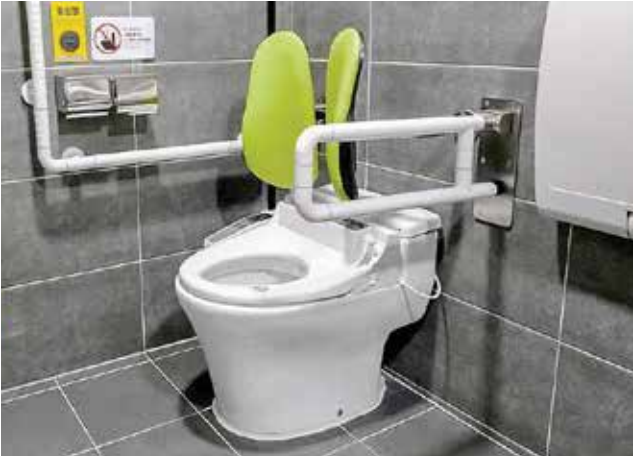
장애인 등받이 및 손잡이 설치
