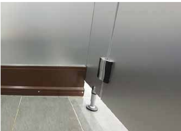
대변기 측면 칸막이 안심스크린 설치
