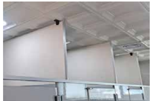
[그림6] 대변기부스 칸막이 상단 안심스크린 설치
