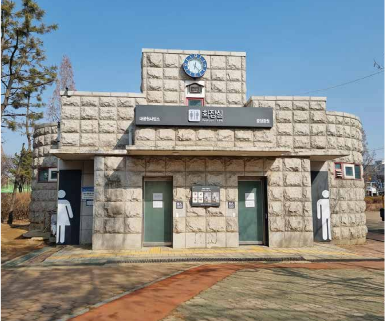
화장실 가이드라인을 설치한 중앙공원3 공중화장실 전경
